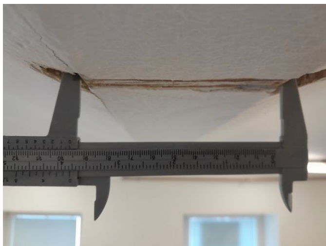
Foto/46/ Šířka ocelového nosníku (cca 96 mm)
