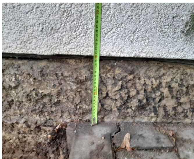
foto/4/ Výška hydroizolace nad terénem/dlažbou
