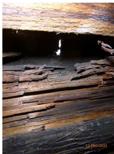
Foto/44/ Poškozená část prkenného podbití
