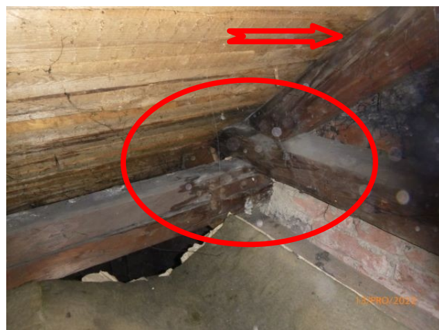
Foto/42/ Stopy vlhkosti na dřevěných prvcích krovu
