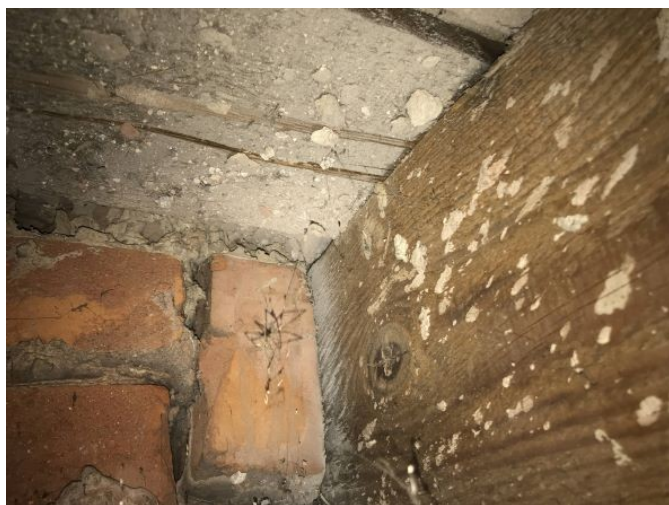
Foto/37/ Pohled na zhlaví stropních trámů
