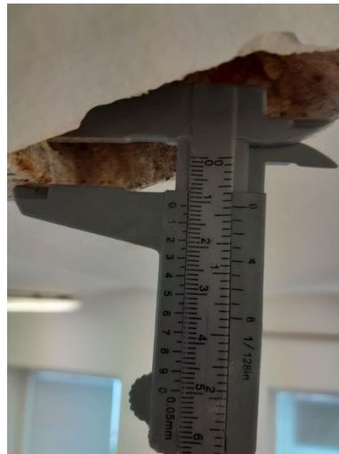
Foto/45/ Tloušťka ocelového nosníku (cca 11 mm)
