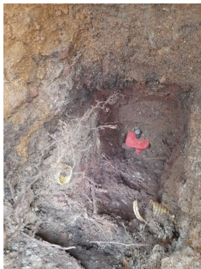
foto/2/ Hloubka základové spáry v sondě K1
