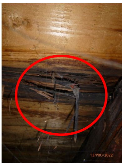
Foto/43/ Poškození dřevěného podbití
