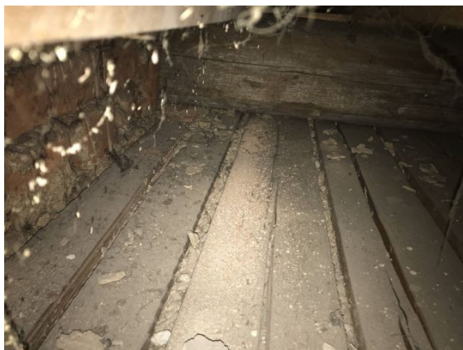
Foto/38/ Pohled na zhlaví stropních trámů
