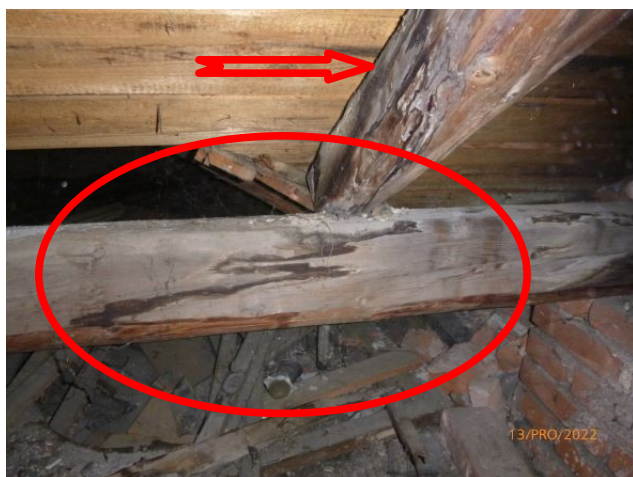
Foto/41/ Stopy vlhkosti na dřevěných prvcích krovu
